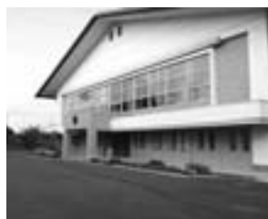
中学校舗装工事
