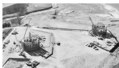
リニア橋梁工事
