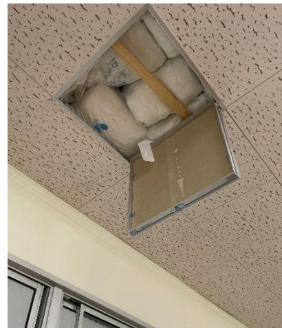
図 66 白馬高校断熱ワークショップ（ワークショップの様子、天井裏の断熱材）
