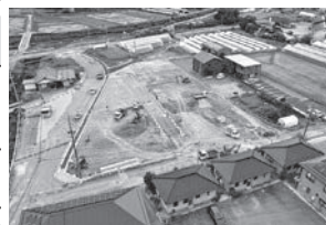
宅地造成事業(中央保育園跡地)
