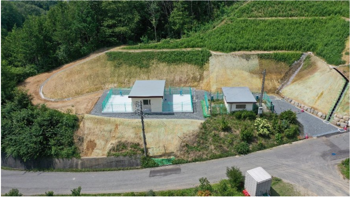
増設工事を完了した帰牛原配水池
