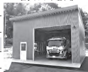
排水ポンプ車 駐車場
