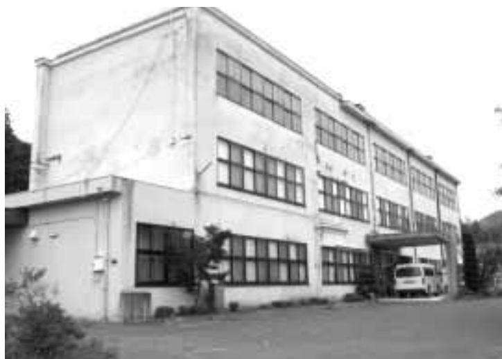
取り壊しが決定している旧中学校校舎
