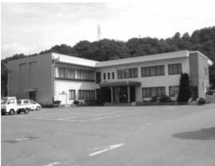
改修工事がされる老人福祉センター
