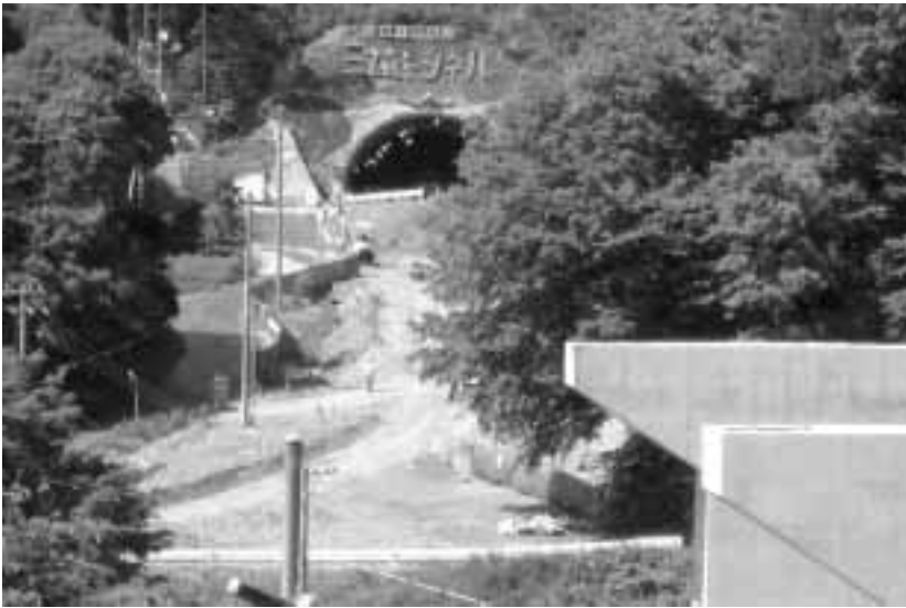
工事が進む三遠南信自動車道、三遠トンネル
