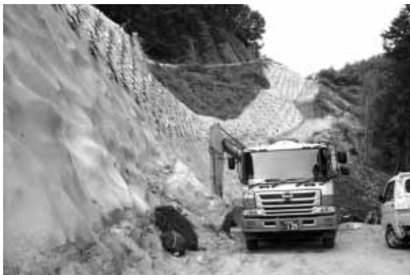
村道7号線工事現場
