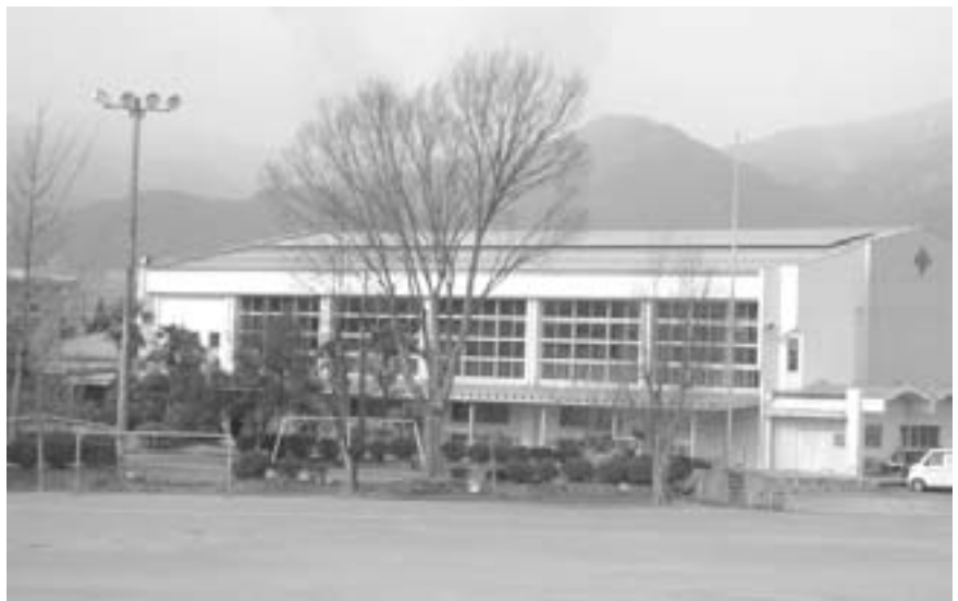
第一小体育館屋根の太陽光発電パネル
