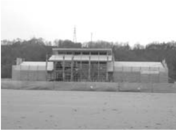
建設中の児童館
