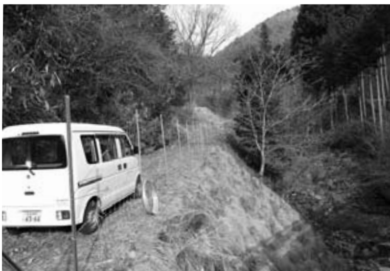
設置が進む防護柵
