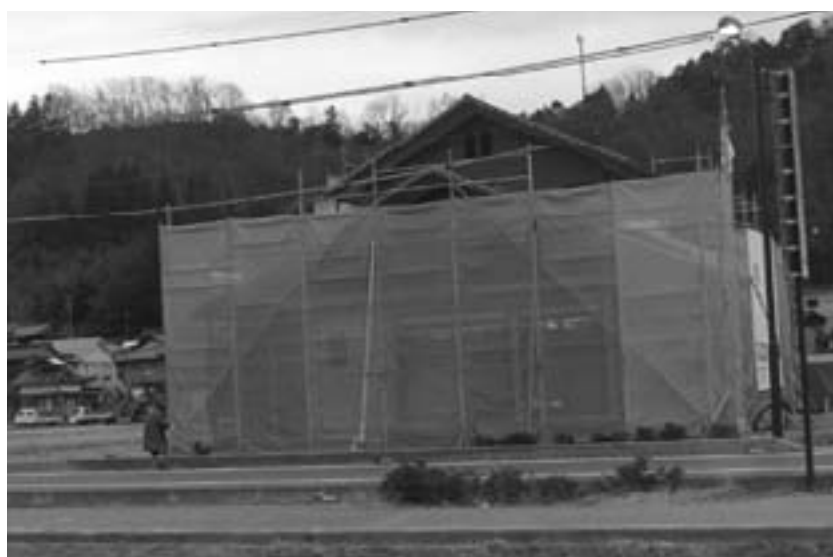
建設中の住宅
