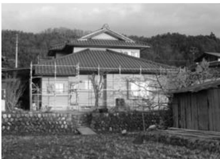
改築中の住宅
