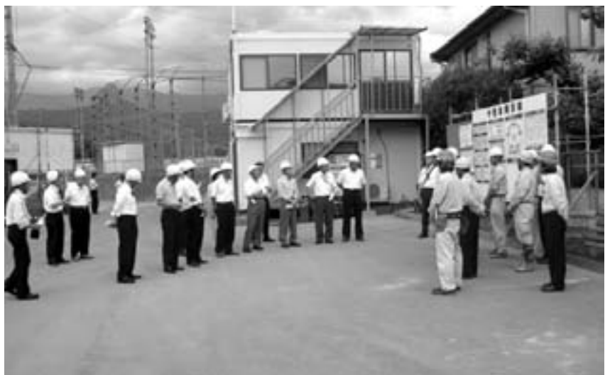
学校調理場建設現場視察
