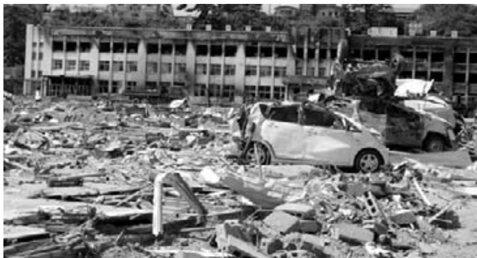
石巻市の被災状況
