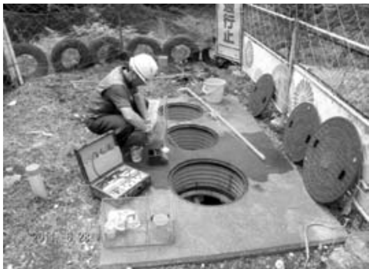
浄化槽の保守点検作業
