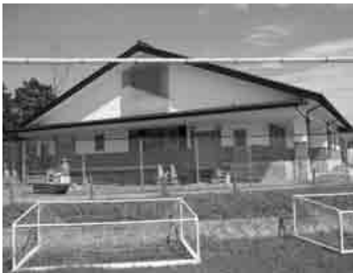
多くの村内企業が参入している学校調理場建設現場
