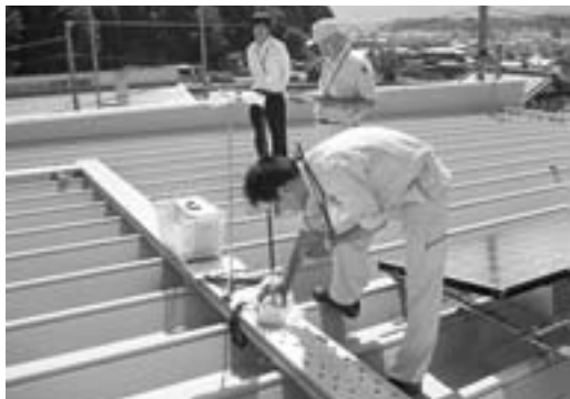
庁舎屋根での放射線量の測定
