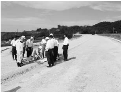
6/18 千代IC(仮称) 工事現場視察
