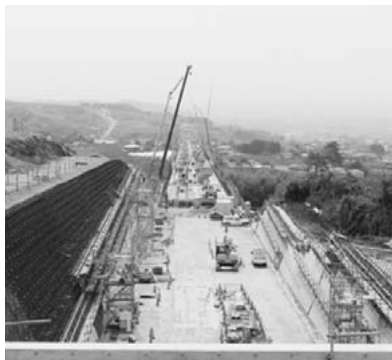
山梨県でのリニア新幹線の工事
