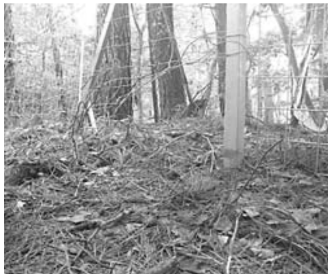
防護柵の破損箇所
