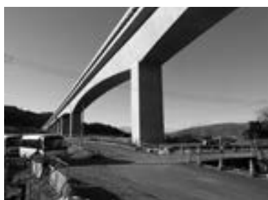
リニア実験線 金川橋梁
