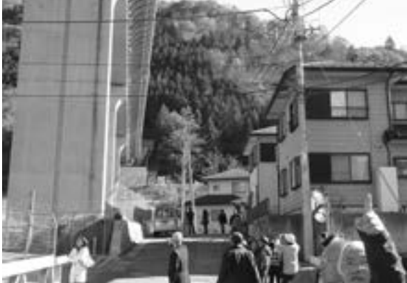
リニア高架橋に近い住宅
