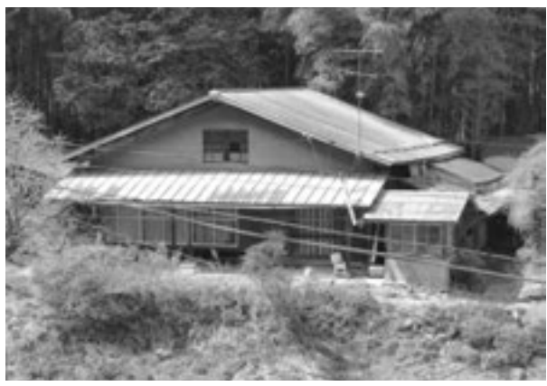
何処にでも見受けられる空き家
