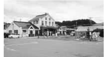
改修される交流センター前広場
