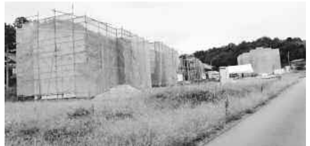
工事が進む 地域優良賃貸住宅
