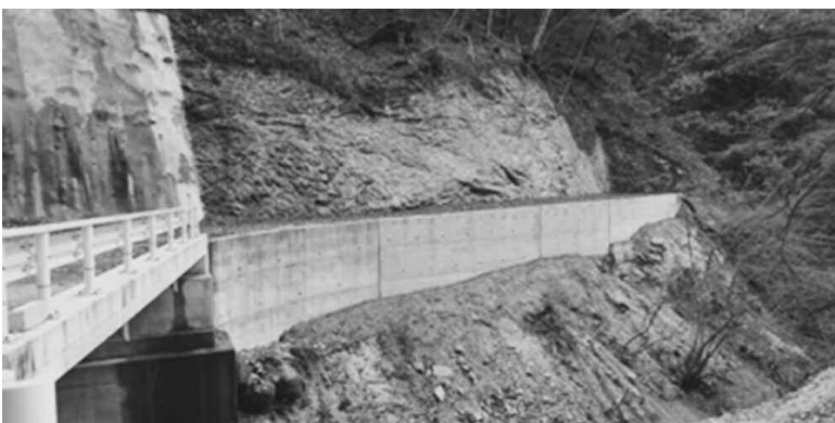
林道最終工事地点
