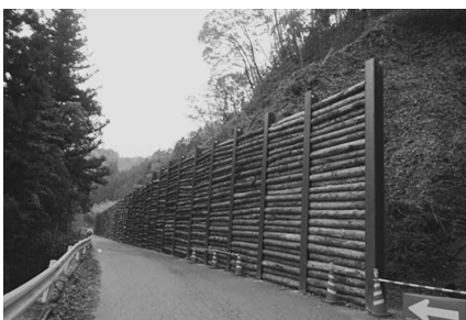
村道7号線落石防護網設置工事状況
