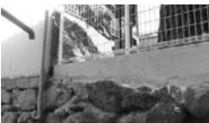
補助金活用し改修されたフェンス
