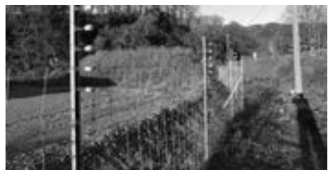
サルの侵入防止電気柵
