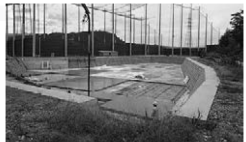
ガイドウェイヤード調整池建設工事の様子
