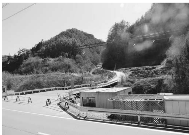
牛首工事用道路 県道上飯田線より取付
