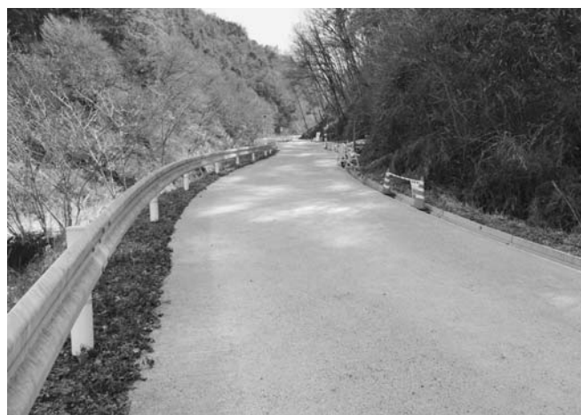
牛首工事用道路 県道上飯田線より100m付近
