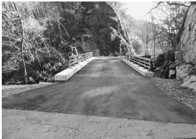
林道胡桃線三遠南信自動車道残土50万㎡搬入道路 県道上飯田線より入口架け替え橋梁
