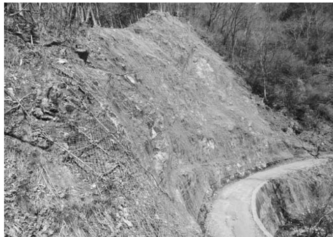
林道胡桃線三遠南信自動車道残土搬入道路 防災工事ネット張り
