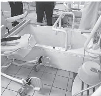
新設の個浴槽
